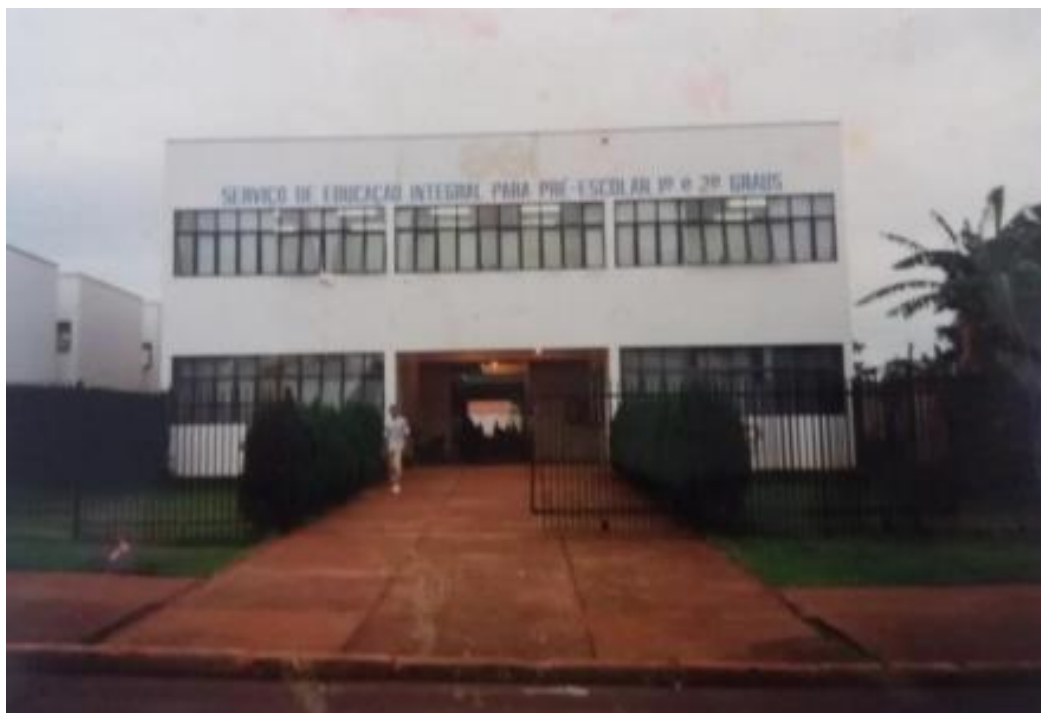
Imagem 04: Fachada da Escola SEI (1992)
